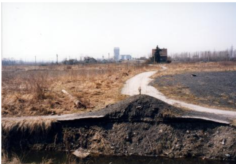
Foto 1 zóna 3 – komunikace jako poslední pozůstatek obytné zástavby Karviná – Darkov, v popředí zřetelný důsledek poddolování a poklesů – extrémně vysoká hladina podzemní vody, dnes zčásti zasypáno a lesnicky rekultivováno, na části ponechány mokré poklesy
