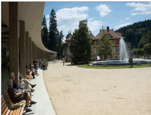
Obr. 22. Kolonáda a Jurkovičův lázeňský dům v Luhačovicích. Foto: Robert Hruban.
