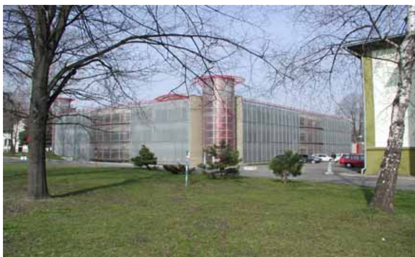
Garážový třípodlažní objekt Černá louka Ostrava v roce 1998
