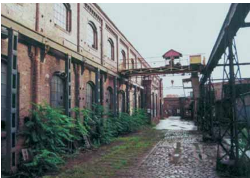
Vaňkovka – strojírna a prostor pod jeřábovou dráhou
