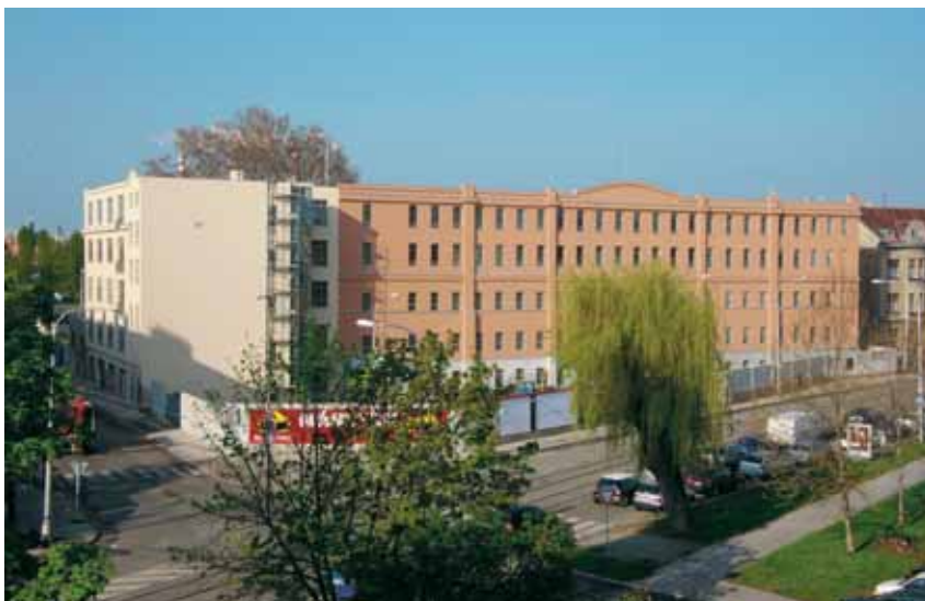
Areál bývalého Moravanu dnes – čelní pohled
