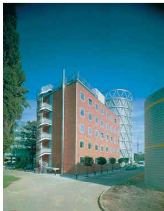
Administrativní budova v areálu JMP a. s.
