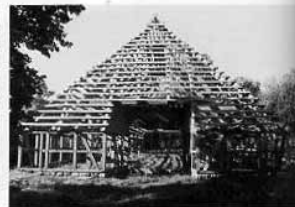
Durchfahrts Haus in Aufbau
