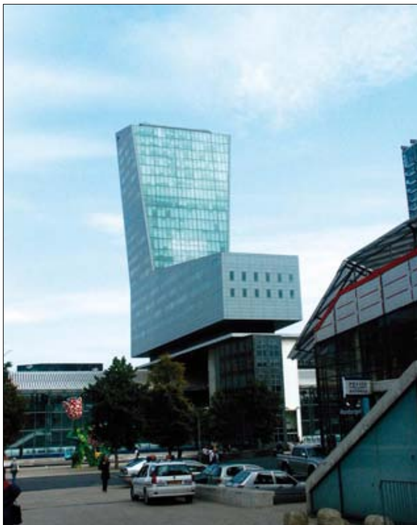
„Lyžařská bota“ – nový symbol města Lille, budova postavená nad nádražím TGV v rámci projektu Euralille.
