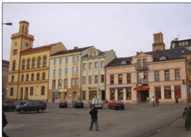
Dolní náměstí – stav před rekonstrukcí
