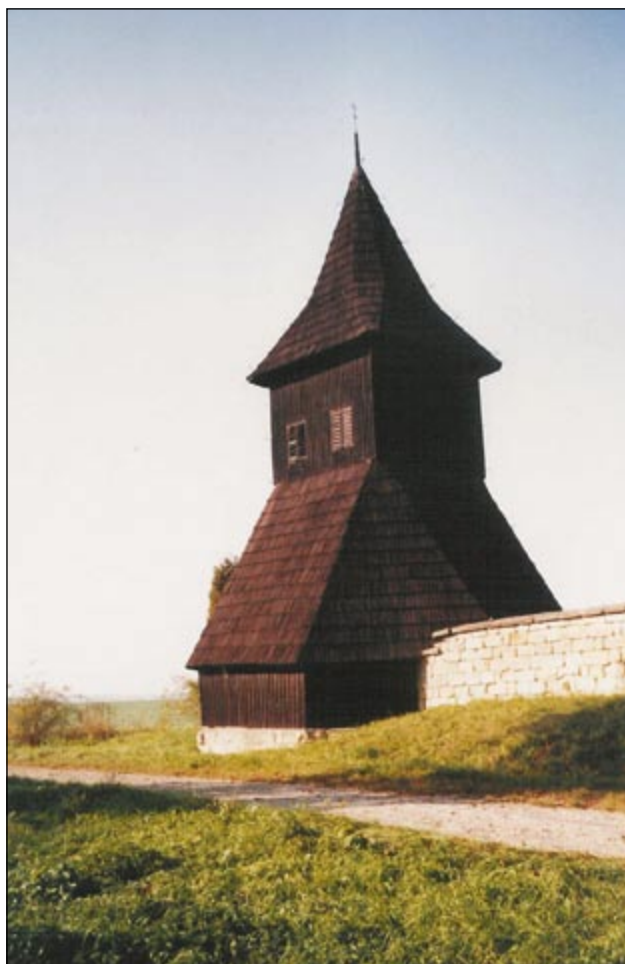
Obr. 4: Psinice – dřevěná zvonice postavená roku 1600, v přízemí osmiboká, výše čtyřboká, se zvonem z roku 1602.
