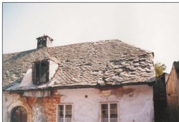
Obr. 2: Jičín – obytný dům s úžasně dochovanou původní břidlicovou krytinou, včetně pokrytí komínu a vikýře, naneštěstí ve špatném stavu.
