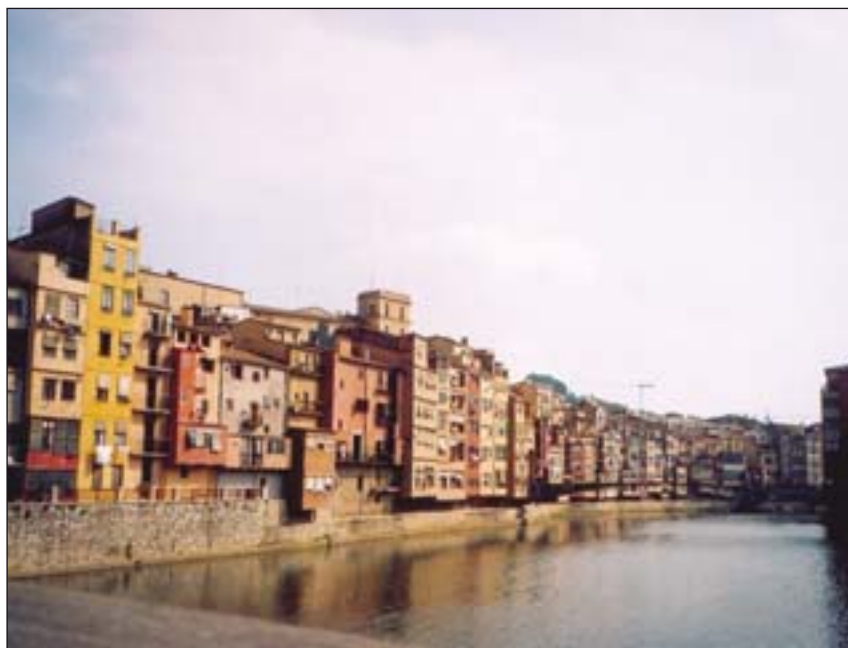
Obr. 1: Rekonstruované historické nábřeží řeky Onyar v Gironě
