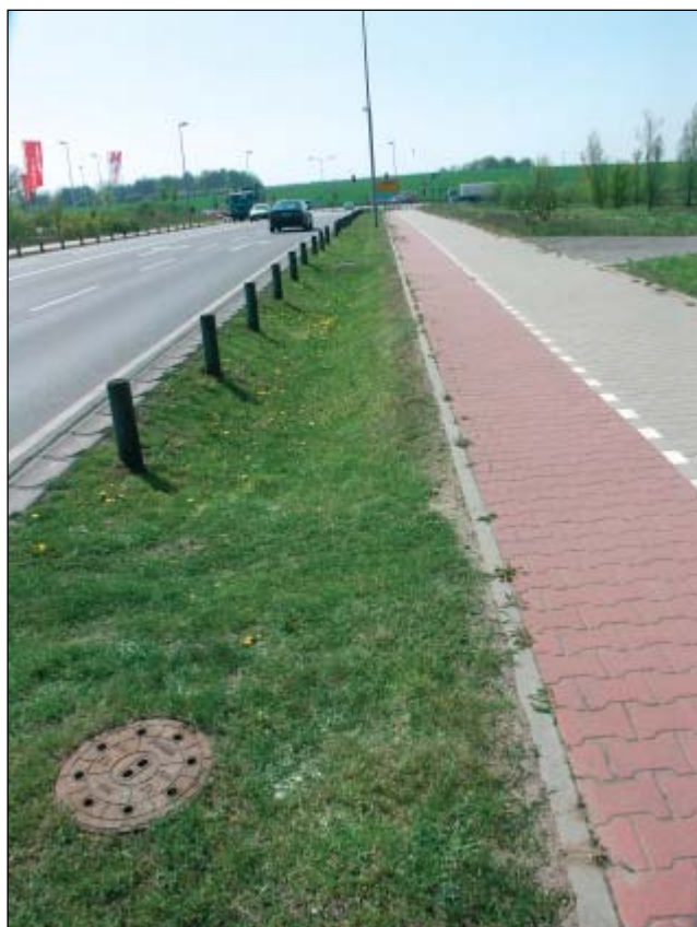
Obr. 12 a 13 – SRN, průmyslová oblast u obce Dahchwitz-Hoppegarten u Berlína – 100ha území s decentralizovaným systémem odvodněním, který zpomaluje a čistí odtok dešťové vody do malého koryta místní vodoteče (autor, 04/2004)
