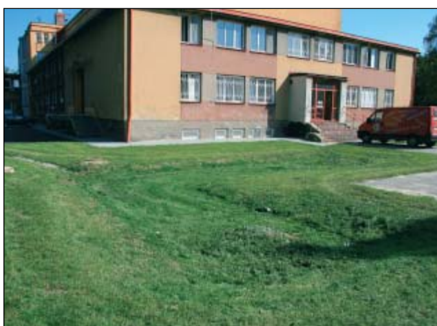
Obr. 8 a 9 – ČR, Karviná – příklad přestavby odvodnění Městského domu kultury v Karviné z konvenčního na decentralizované se zasakovacími průlehy a retenčními příkopy realizované při projektu RainDROP (autor, 2006)
