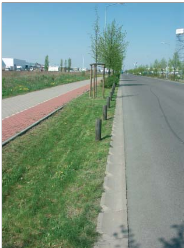
Obr. 12 a 13 – SRN, průmyslová oblast u obce Dahchwitz-Hoppegarten u Berlína – 100ha území s decentralizovaným systémem odvodněním, který zpomaluje a čistí odtok dešťové vody do malého koryta místní vodoteče (autor, 04/2004)
