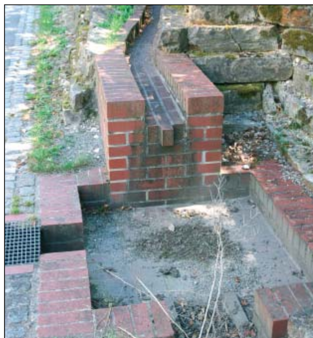
Obr. 18 – SRN, Ulm - odvodnění univerzitého kampusu je provedeno tak, aby cesta dešťové vody byla vidět, a aby mohla dotéct do průlehů nebo mokřadů nebo poldrů ... (autor, 2007)
