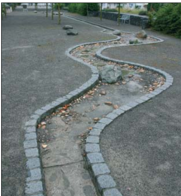
Obr. 17 – SRN, Asperg v povodí řeky Emscher, parková úprava decentralizovaného odvodnění (autor, 2007)
