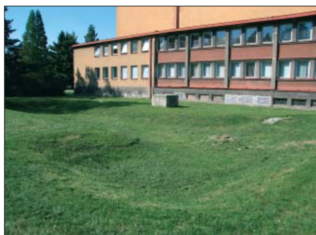
Obr. 8 a 9 – ČR, Karviná – příklad přestavby odvodnění Městského domu kultury v Karviné z konvenčního na decentralizované se zasakovacími průlehy a retenčními příkopy realizované při projektu RainDROP (autor, 2006)
