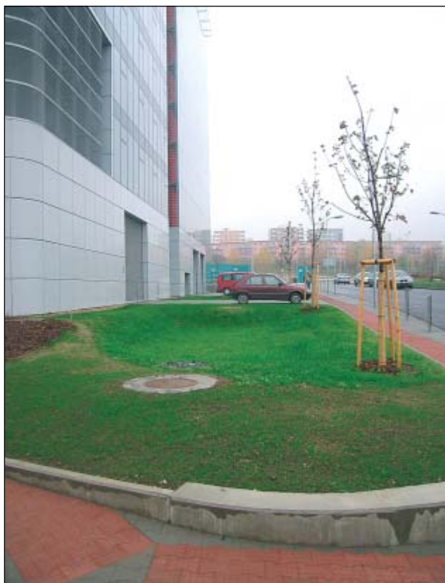
Obr. 10 a 11 – ČR, Brno - Masarykova univerzita, univerzitní kampus v Bohunicích a Moravský zemský archív – ukázka rozestavného retenčního příkopu a vedle hotového zasakovacího průlehu, pod kterým je stejná konstrukce retenčního příkopu (autor, 2007)
