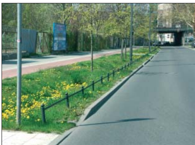
Obr. 6 – SRN, Berlín – Wasserstadt Rummelsburg na řece Spree – Tunnelstrasse – ulice s provozem MHD odvodněná prostřednictvím prvků průlehl-příkop ke zpomalení odtoku (autor, 04/2004)
