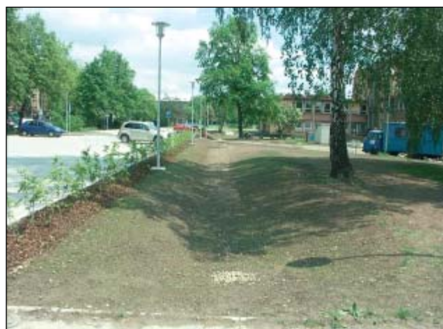
Obr. 7 – ČR, Karviná – příklad odvodnění parkoviště zasakovacím průlehem a retenčním příkopem (bez použití odlučovačů lehkých kapalin) u Městského domu kultury v Karviné realizovaného při projektu RainDROP (autor, 2006)
