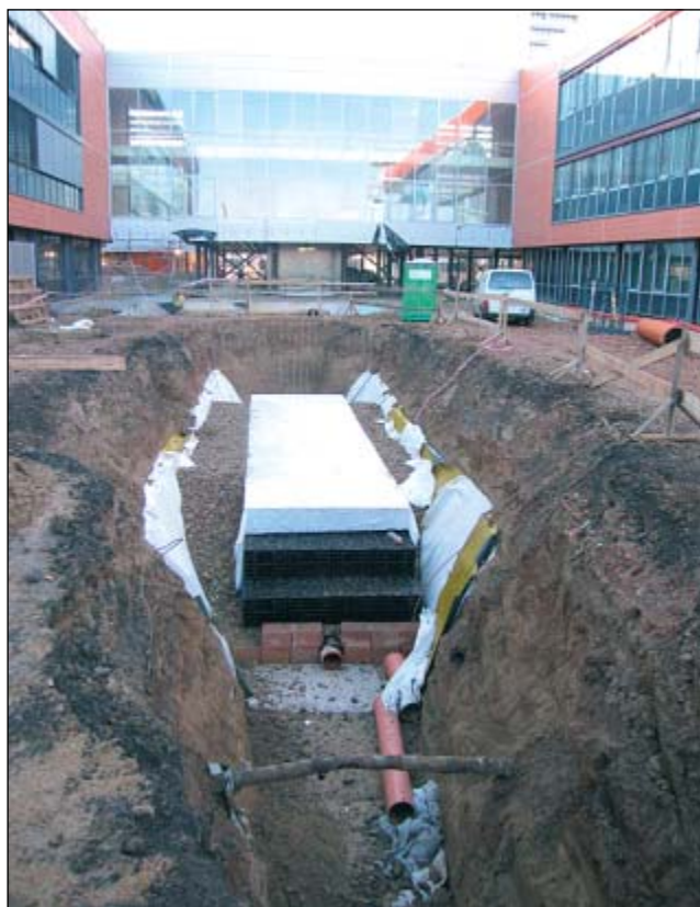
Obr. 10 a 11 – ČR, Brno - Masarykova univerzita, univerzitní kampus v Bohunicích a Moravský zemský archív – ukázka rozestavného retenčního příkopu a vedle hotového zasakovacího průlehu, pod kterým je stejná konstrukce retenčního příkopu (autor, 2007)
