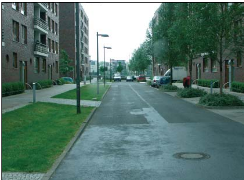
Obr. 5 – SRN, Berlín – Wasserstadt Rummelsburg na řece Spree – na poloostrově Stralau byla od poloviny 19. století do r. 1992 průmyslová zóna, po r. 1999 je přestavěna na bydlení a práce u vody – městský urbanismus podle principů udržitelného rozvoje s odvodněním prostřednictvím zasakovacích průlehlů a retenčních příkopů. Velice ukázkový příklad dispozitivního uspořádání ulice s decentralizovaným systémem odvodnění (autor, 05/2004)
