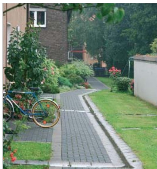
Obr. 14, 15 a 16 – SRN, město Lunen v povodí řeky Emscher, obyvatelé skupiny asi 10 činžovních domů nechali proto, aby nemuseli platit za odvádění dešťové vody stočné, přestavět stávající konvenční odvodnění na decentralizované se vsakem do podzemí (autor, 2007)
