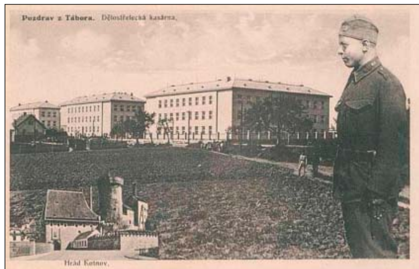
Obr. 1: Původní kasárna (dobová pohlednice)
