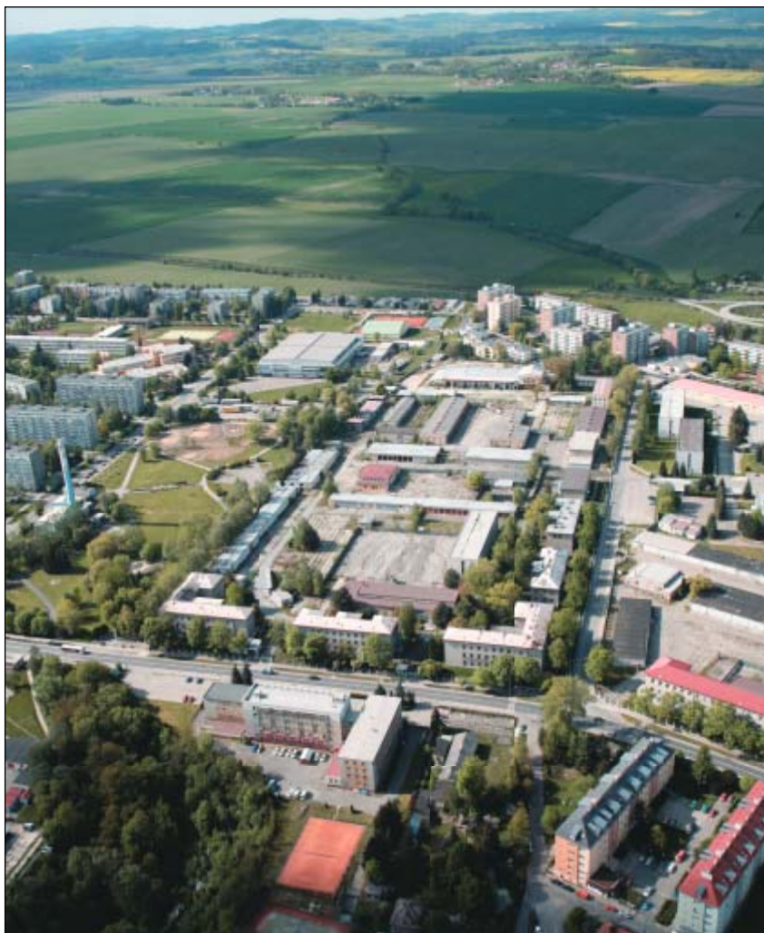
Obr. 2: Letecký pohled na stávající areál kasáren
