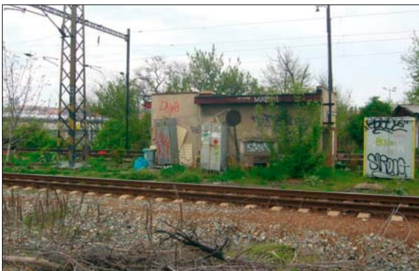
Obr. 6: Pozůstatky drážních domků, které slouží jako útočiště bezdomovců
