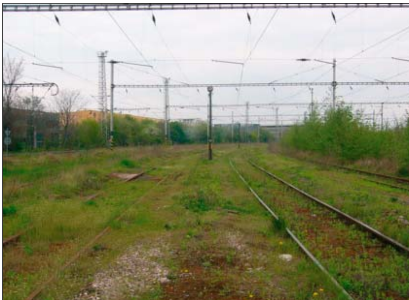
Obr. 2: Pohled na kolejiště směřem od Vršovic
