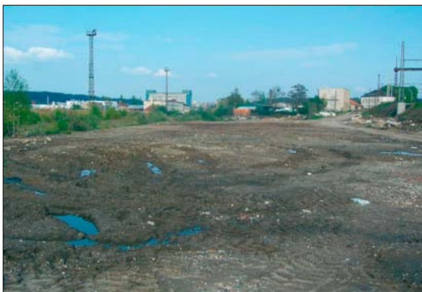
Obr. 22: Část území už je i bez kolejového lože...
