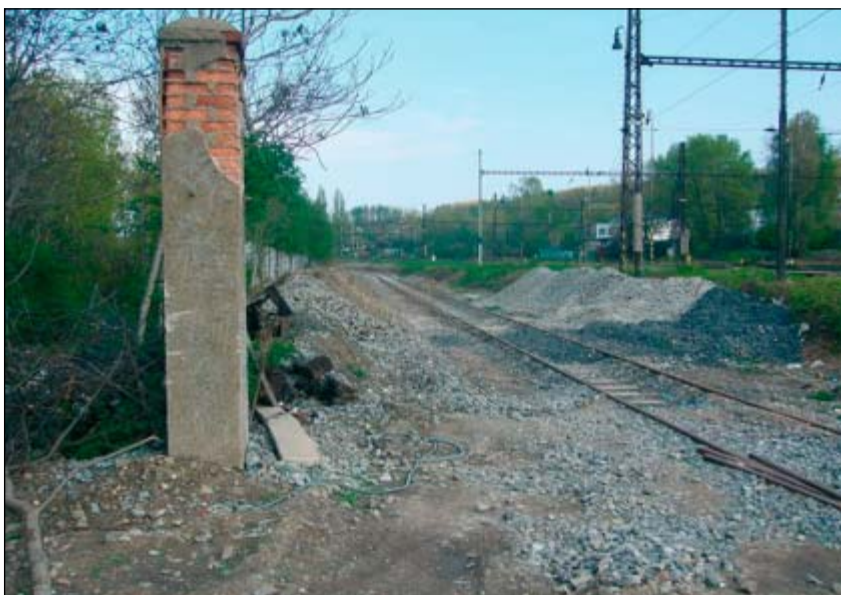
Obr. 17: Dřívější přiváděcí kolej z předávacího nádraží ke stanici Praha Libeň
