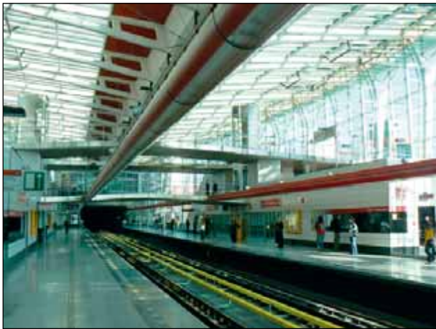
Stanice metra Střížkov
