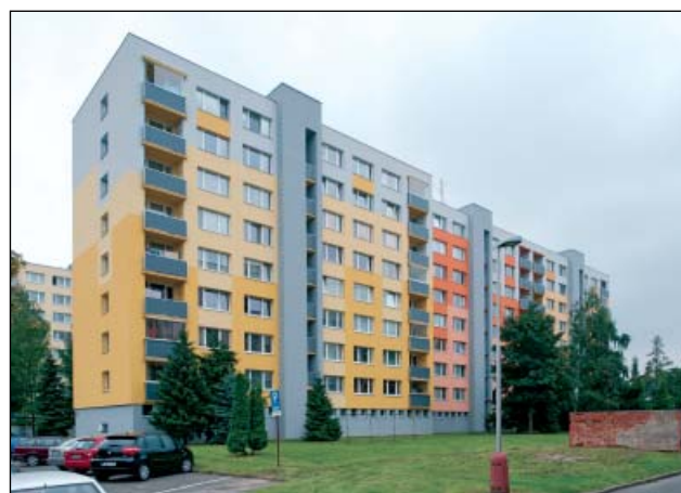
Mladá Boleslav – projekt regenerace bytového domu, stav po ukočení realizace
