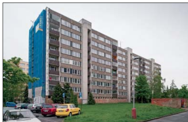
Mladá Boleslav – projekt regenerace bytového domu, stav před realizací
