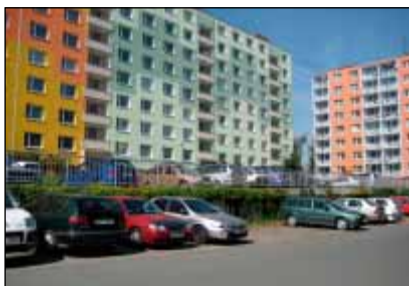
Parkovací stání ve dvou úrovních, dělicí zeď – sídliště Osvobození ve Vyškově
