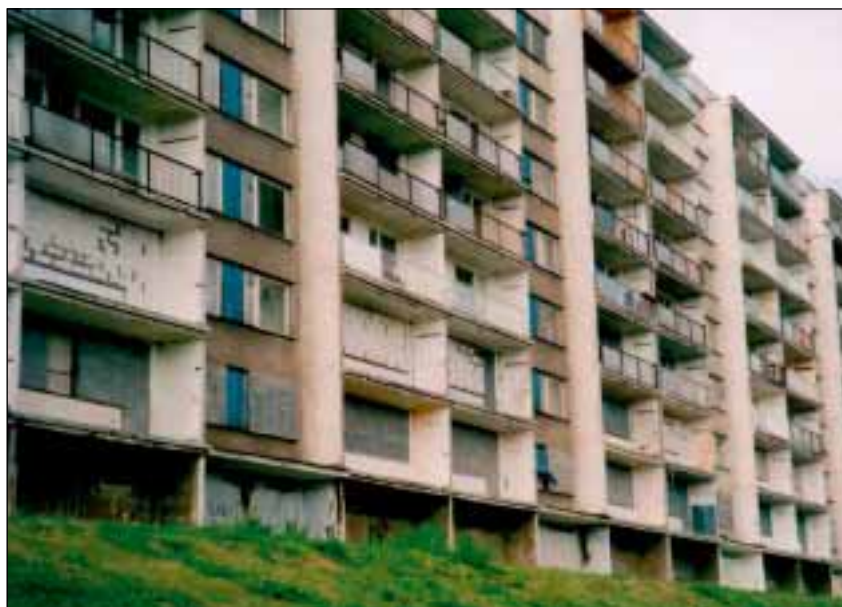
Obr. 6: Zapečetěný panelový dům o devíti vchodech (135 bytů) v Gluckově ulici. Vstupy do objektu a okna do výše 1. patra jsou zazděny. Balkonová zábradlí ve spodních podlažích jsou preventivně odstraněna.
