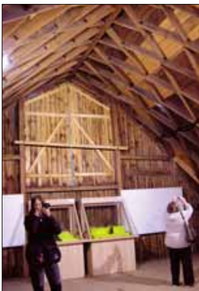
Schindlerova stodola v Malé Morávce
