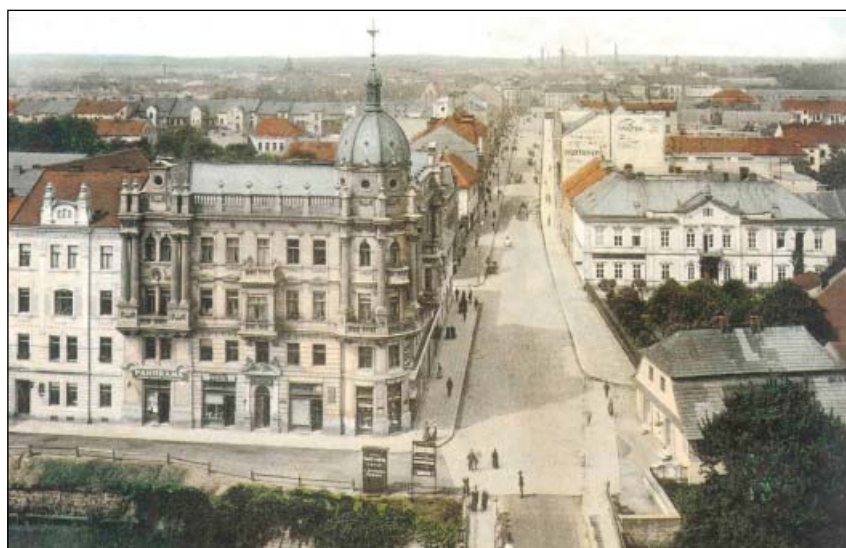
Obr. 6: Pohled ze Zelené brány na hlavní osu předměstí, v popředí hradební příkop s vodním kanálem
