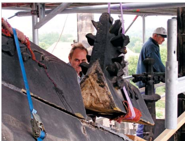
Pražský hrad, katedrála sv. Víta, demontáž dílu opěrného oblouku chóru
