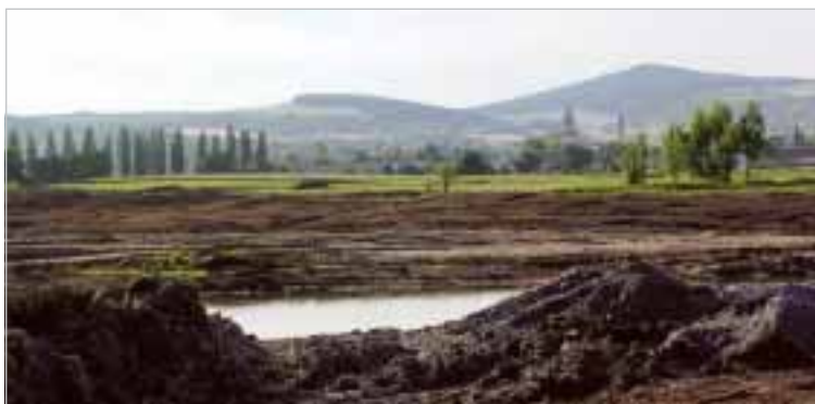
Realizace – přípravné práce, podzim 2010
