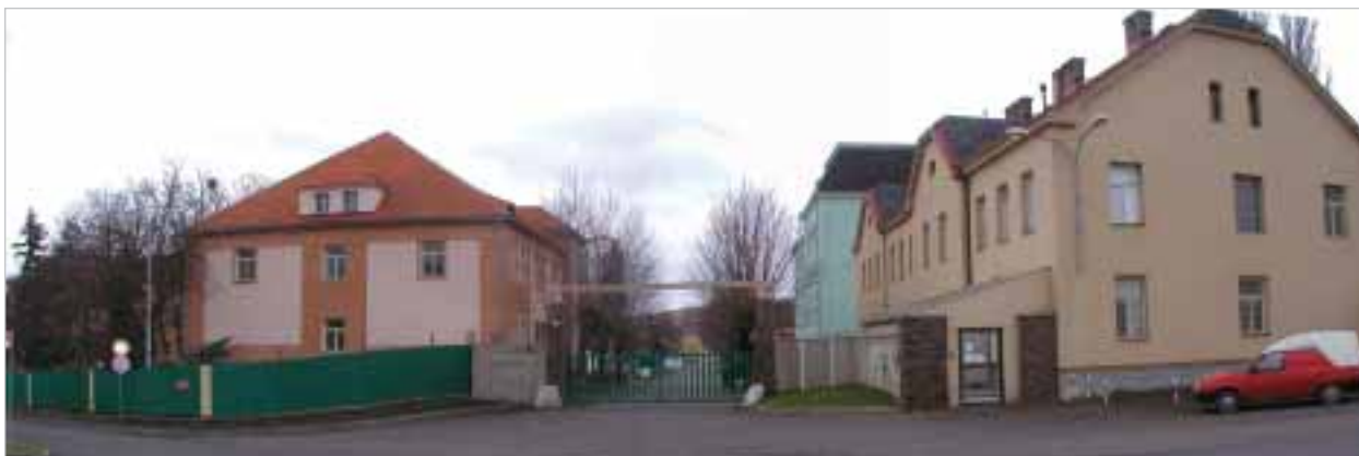
Hlavní vstup do areálu kasáren z Kamýčké ulice, hlavní severojižní osa areálu
