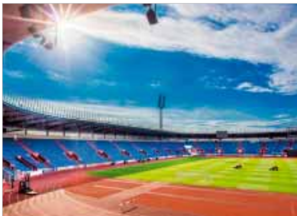
Rekonstrukce městského stadionu v Ostravě-Vítkovicích
