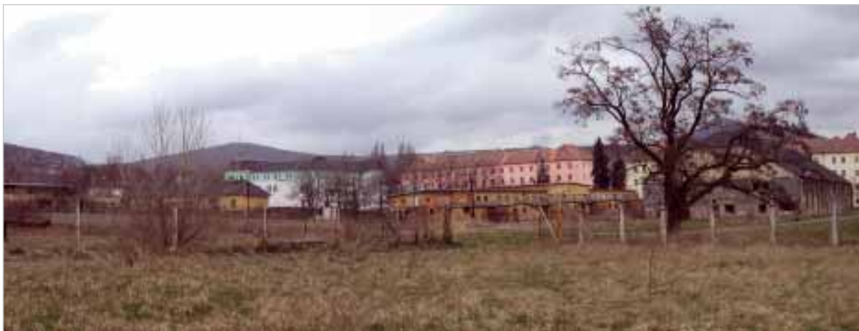
Celkový pohled na severozápadní část areálu od jihovýchodu
