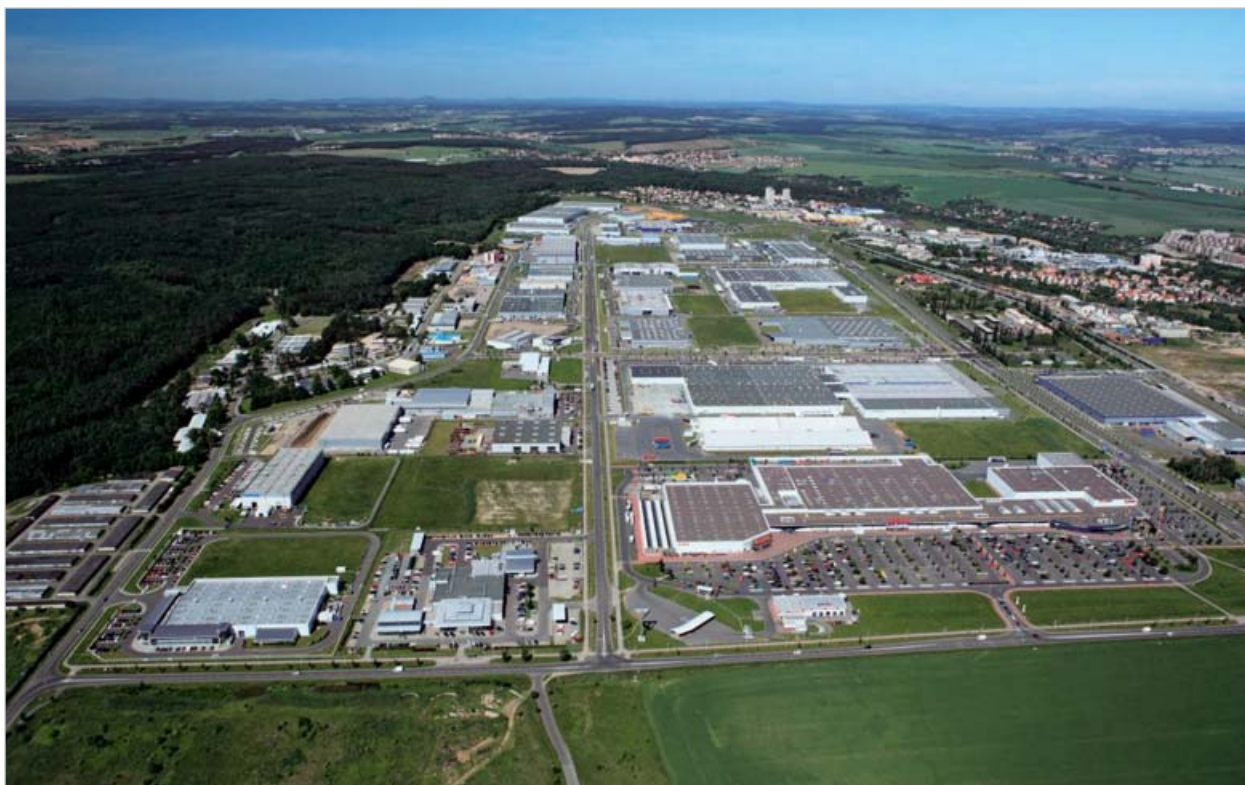
Průmyslová zóna Borská pole
