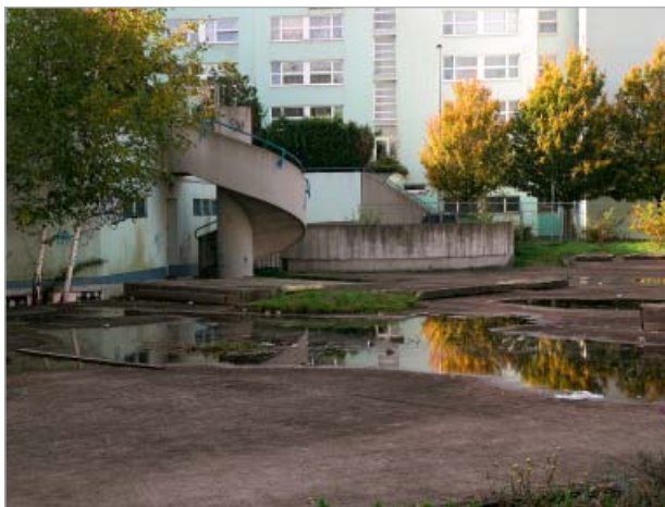
Ohrožení veřejných prostorů zanedbaností (Černý most, Praha)
