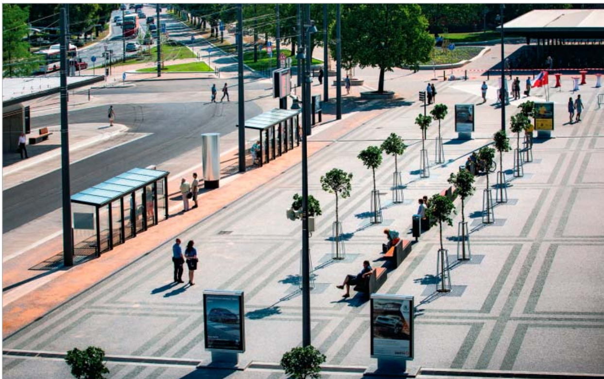
Multimodální uzel veřejné dopravy v Pardubicích, autoři: Tomáš Med, Lukáš Pavlík, Jindřich Kmoníček, Jiří Nývlt (2017)
