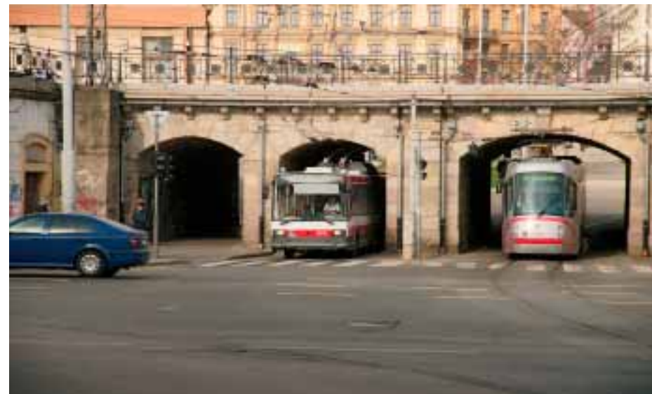
Viadukt u nádraží v Brně
