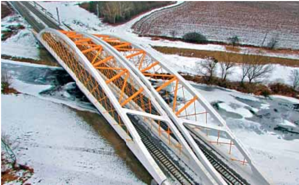
Rekonstrukce mostu na trati Hohenau – Přerov (Václav Kocián, David Rose, EXprojekt s. r. o., 2016; realizace: Firesta a. s. 2016; vítěz soutěže 5 th European Steel Bridge Awards 2018)
