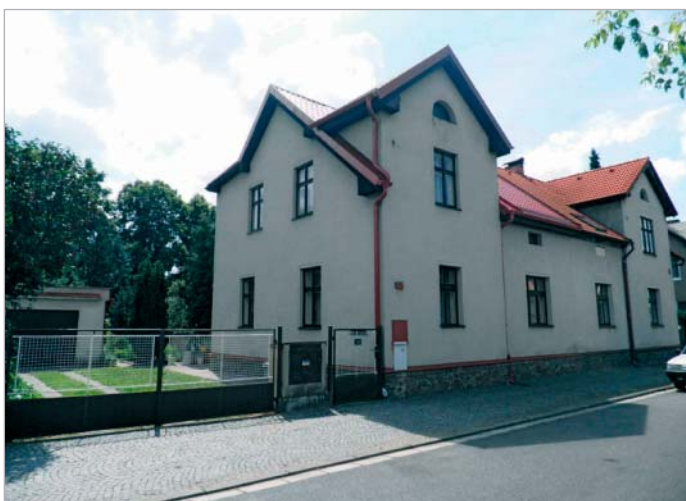
Domov sociálních služeb Slatiňany, služba chráněného bydlení – komunitní objekt Slatiňany
