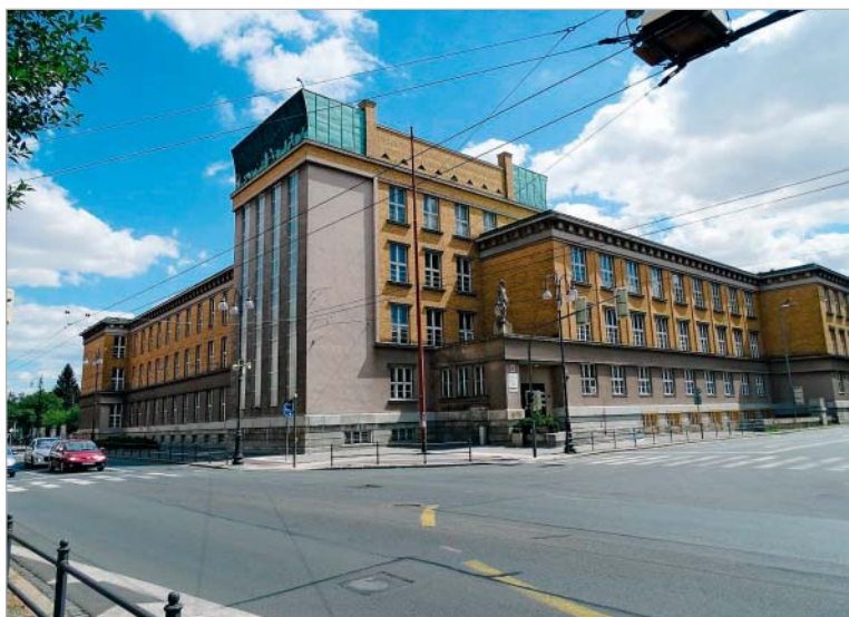
Realizace úspor energie – SPŠE a VOŠ Pardubice, budovy A, B a D
