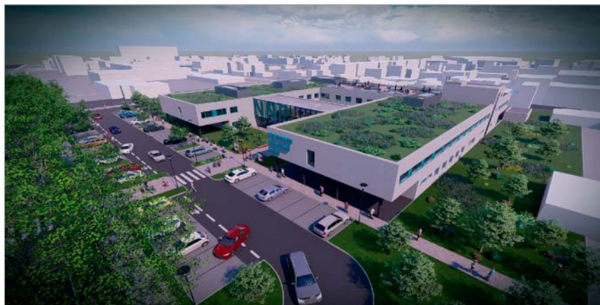
Nemocnice následné péče Moravská Třebová – výstavba nového objektu nemocnice a výjezdové základny ZZS PAK
