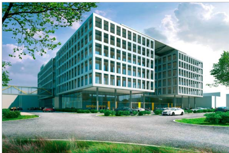
Pardubická nemocnice – výstavba pavilonu centrálního urgentního příjmu
