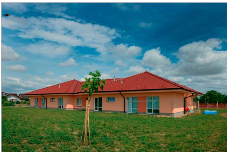
Domov sociálních služeb Slatiňany, služba domovy pro osoby se zdravotním postižením – komunitní objekt Bylany
