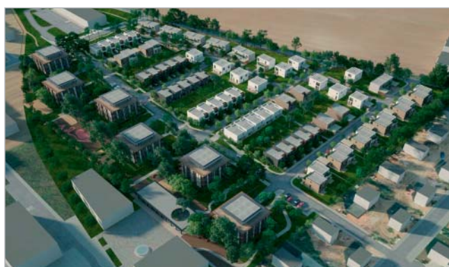
Nová rezidenční čtvrť Přezletice - Panská pole
