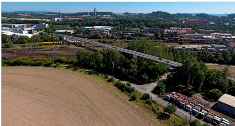
Křížení východní části obchvatu se železniční tratí č. 270
