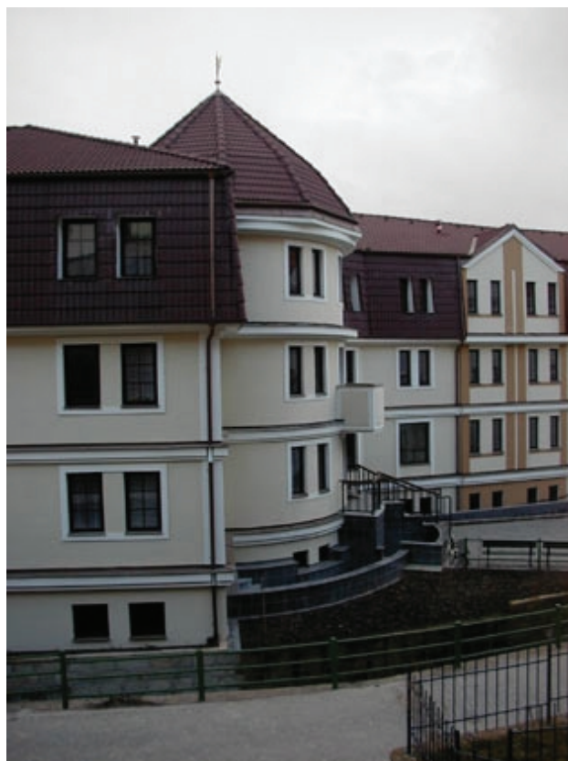
DPS Chrudim – pohled z ulice
