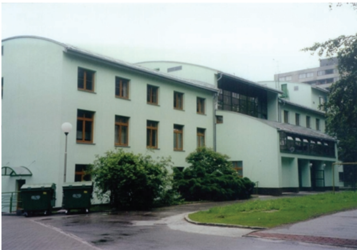
DPS Ostrava – Poruba, společenská část s 11 byty
