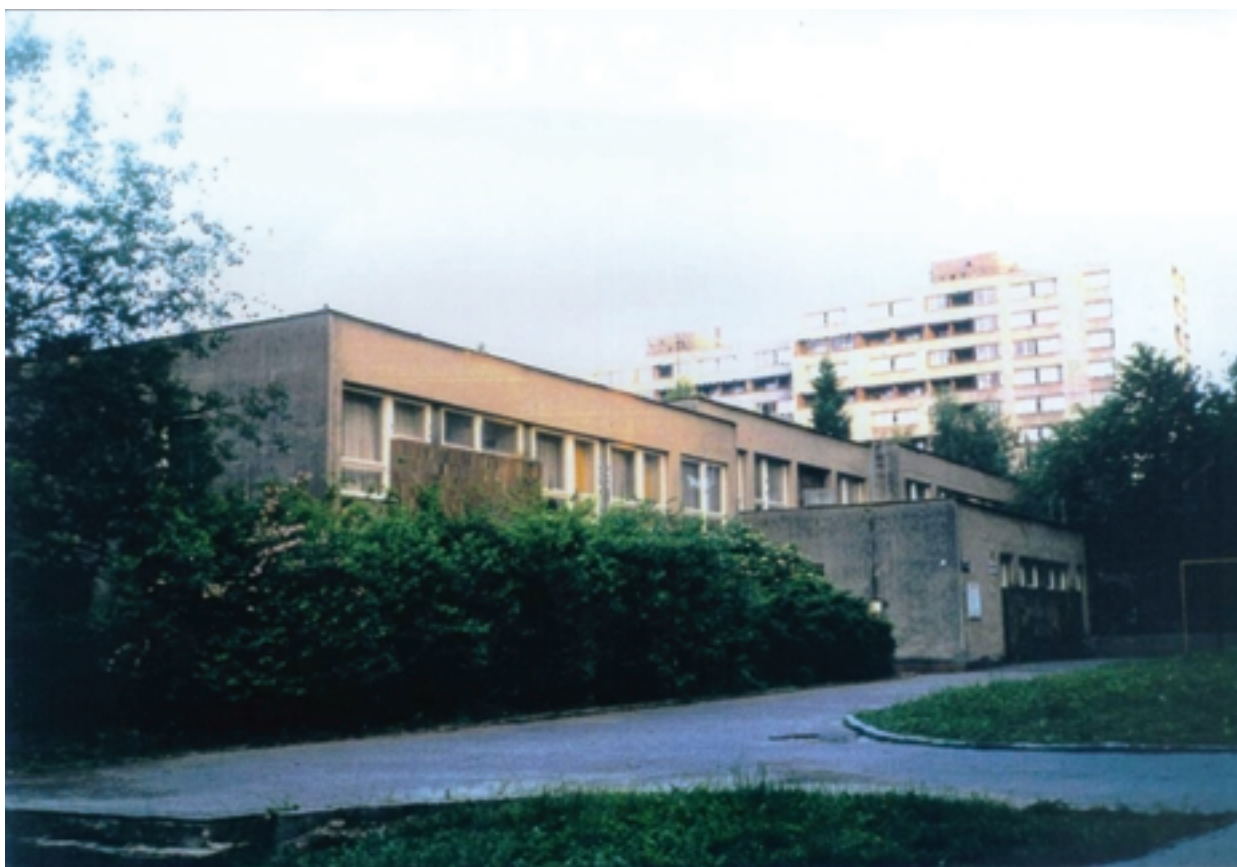
DPS Ostrava – Poruba, objekt před rekonstrukcí
