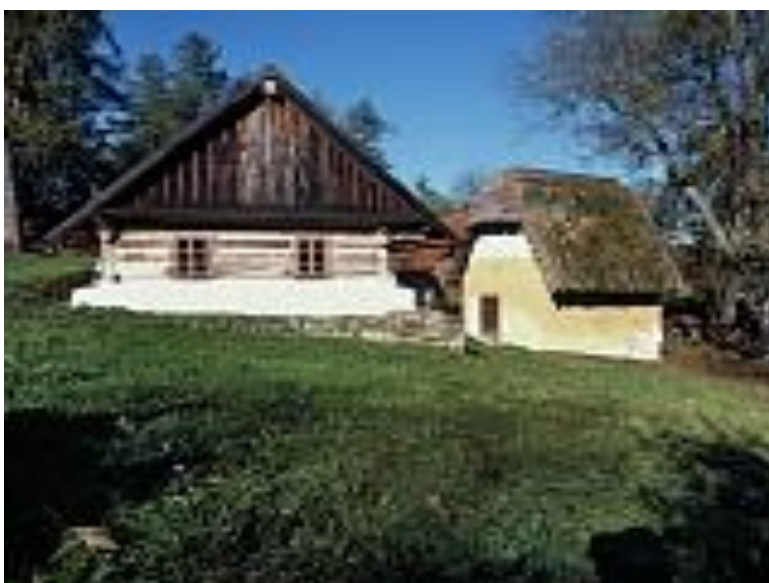
Stavby na předhradí Velhartice
