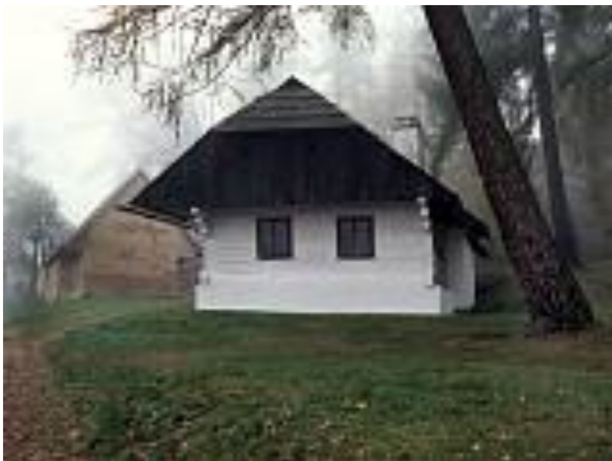
Stavby na předhradí, Velhartice
