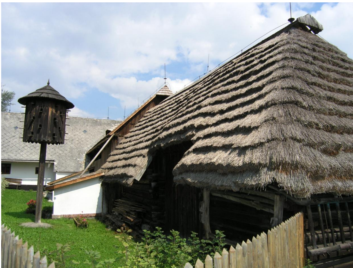
Původní usedlost č. p. 4, Veselý Kopec
