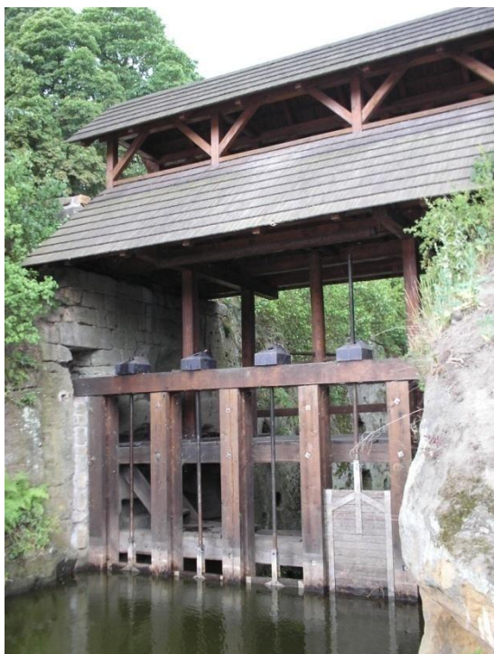
Propust na Novozámeckém rybníku Zahrádky
