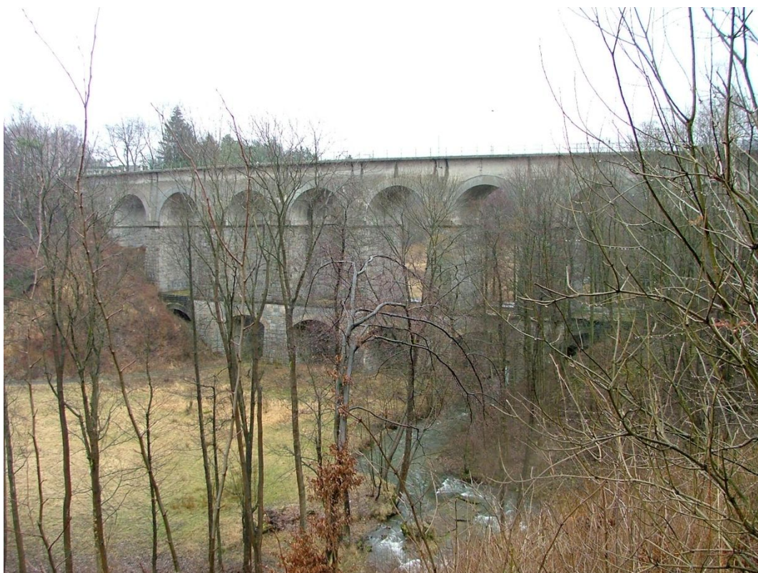
Zámecký vodovod Sychrov
