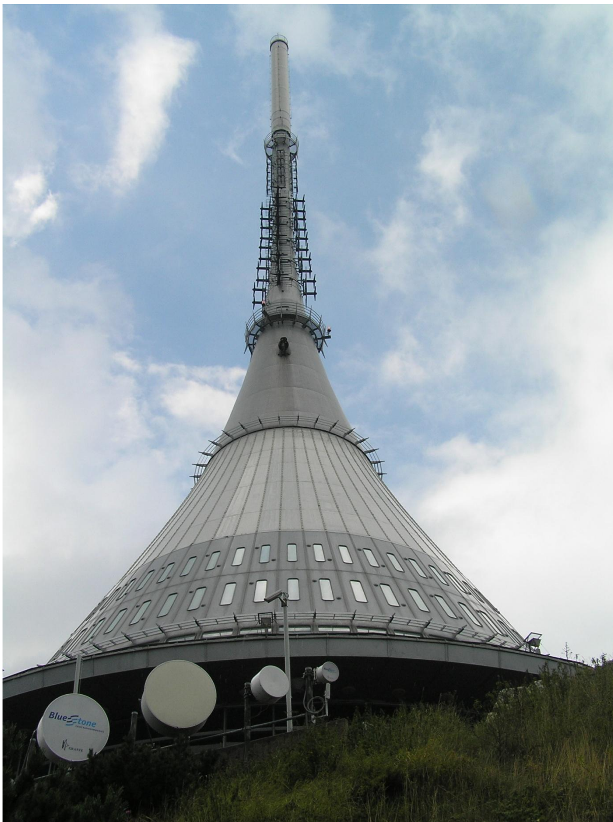
Televizní vysílač Ještěd
