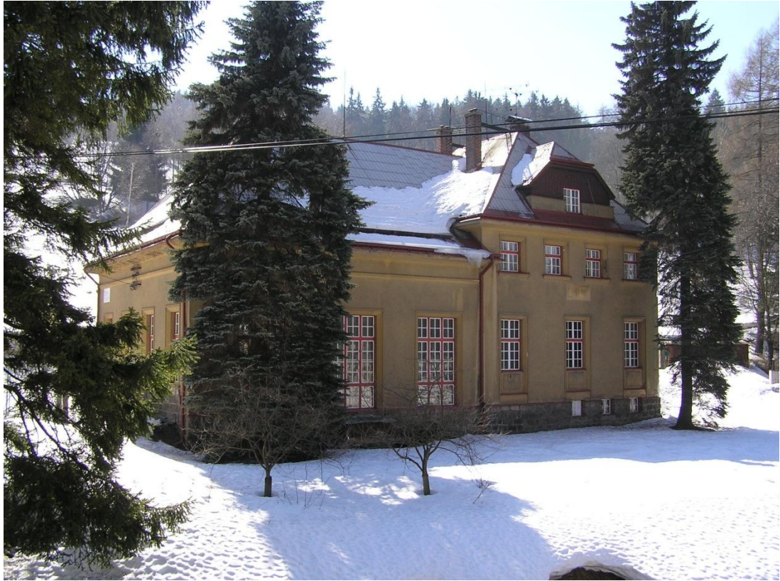
Elektrárna Liberec – Rudolfov
