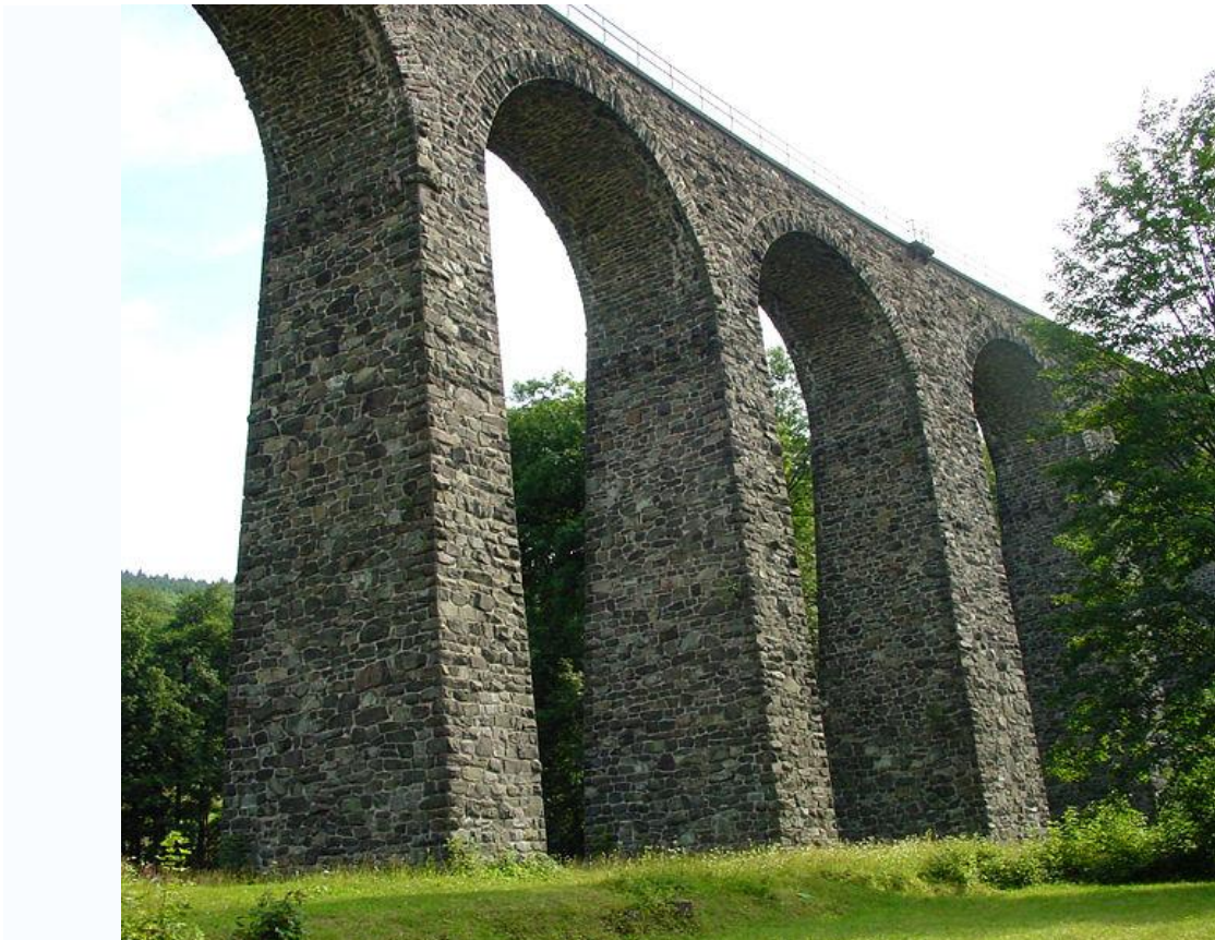
Železniční viadukt Kryštofovo údolí – Novina cs.wikipedia.org/wiki/Kryštofovo_Údolí - 32k -
