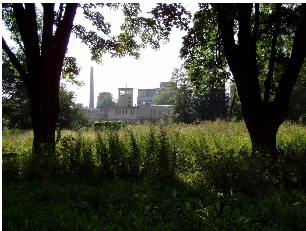
Areál firmy Odetka, bývalé bělidlo příze, Vrbno pod Pradědem
