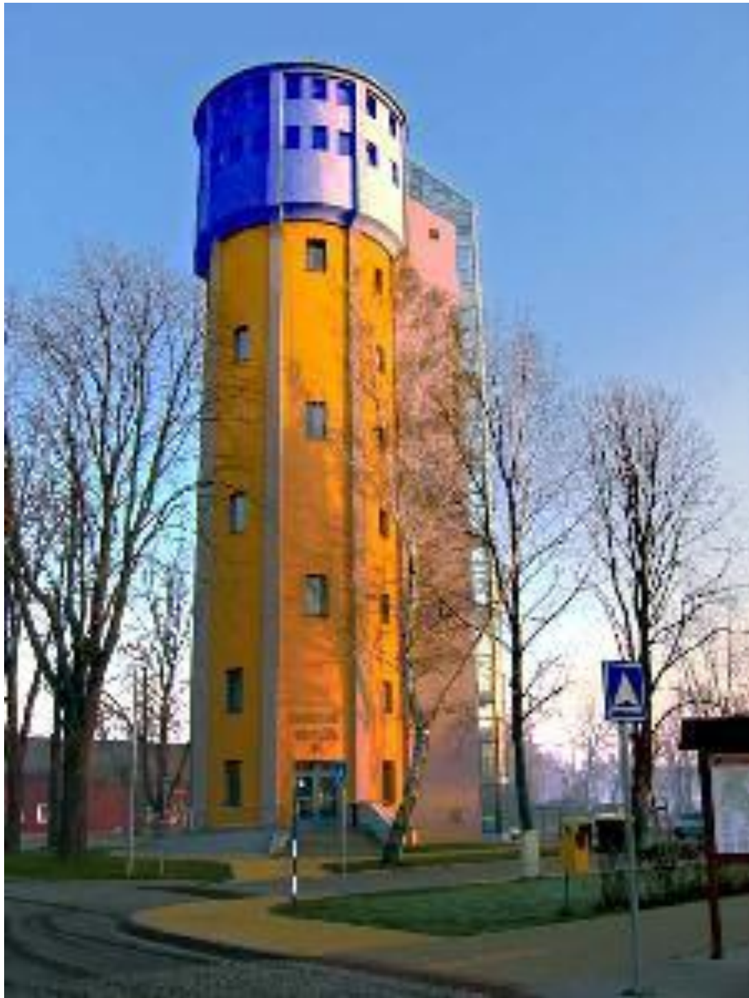
Vodárenská věž Bohumín www.hrady.cz
