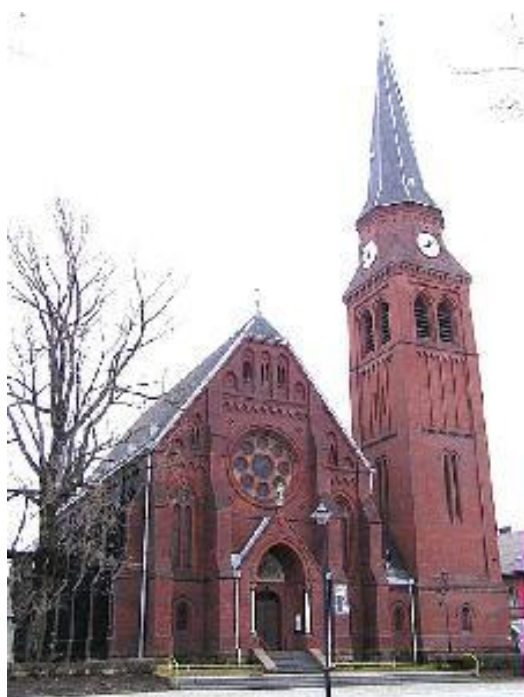
Vodárenská věž – kostel sv. Pavla Ostrava www.hrady.cz
