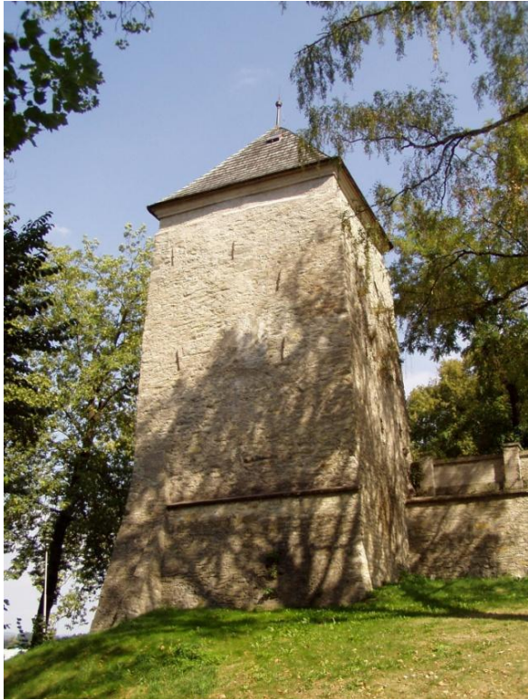
Vodárenská věž Vysoké Mýto
