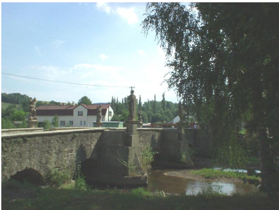
Barokní silniční most Bělá nad Radbuzou
