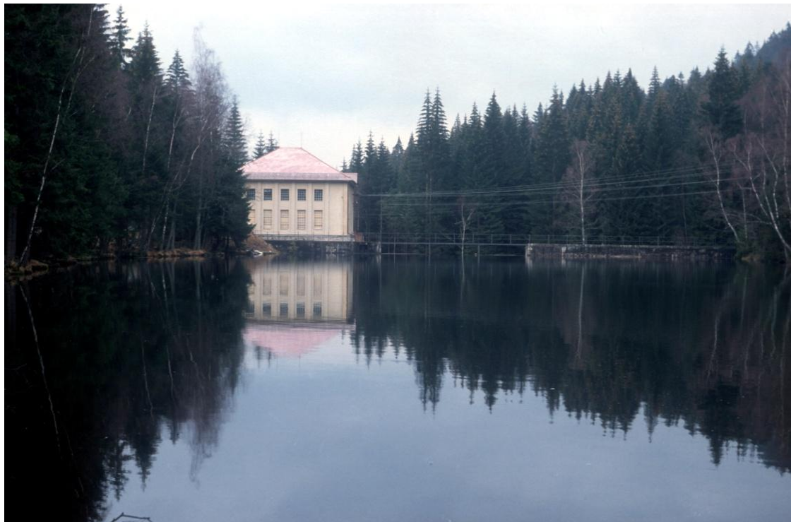
Vodní elektrárna Železná Ruda – Hojsova Stráž
