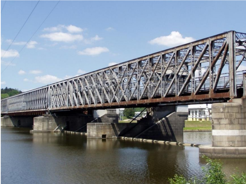
Most a elektrárna Mířejovice
