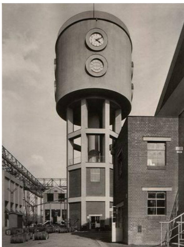
Plynárna Michle www.e-architekt.cz/index.php
