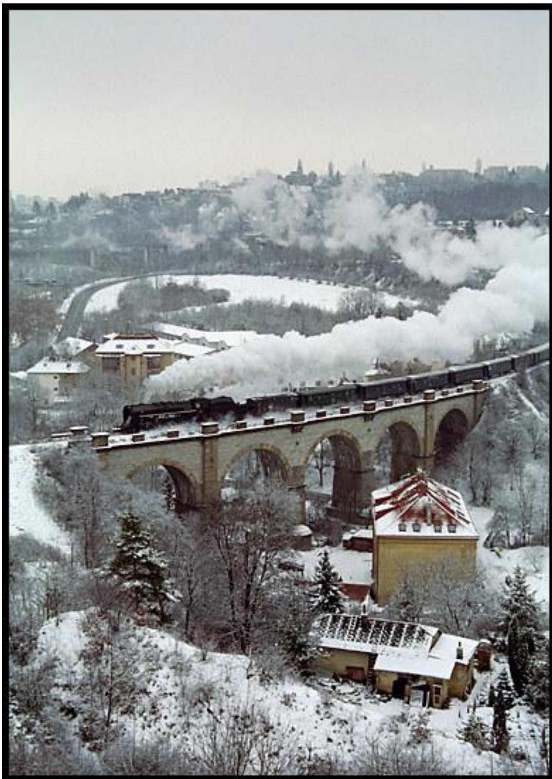
Viadukty Buštěhradské dráhy – Pražský Semmering http://www.martinvalek.net/zeleznice/cesko/praha-semmering.html
