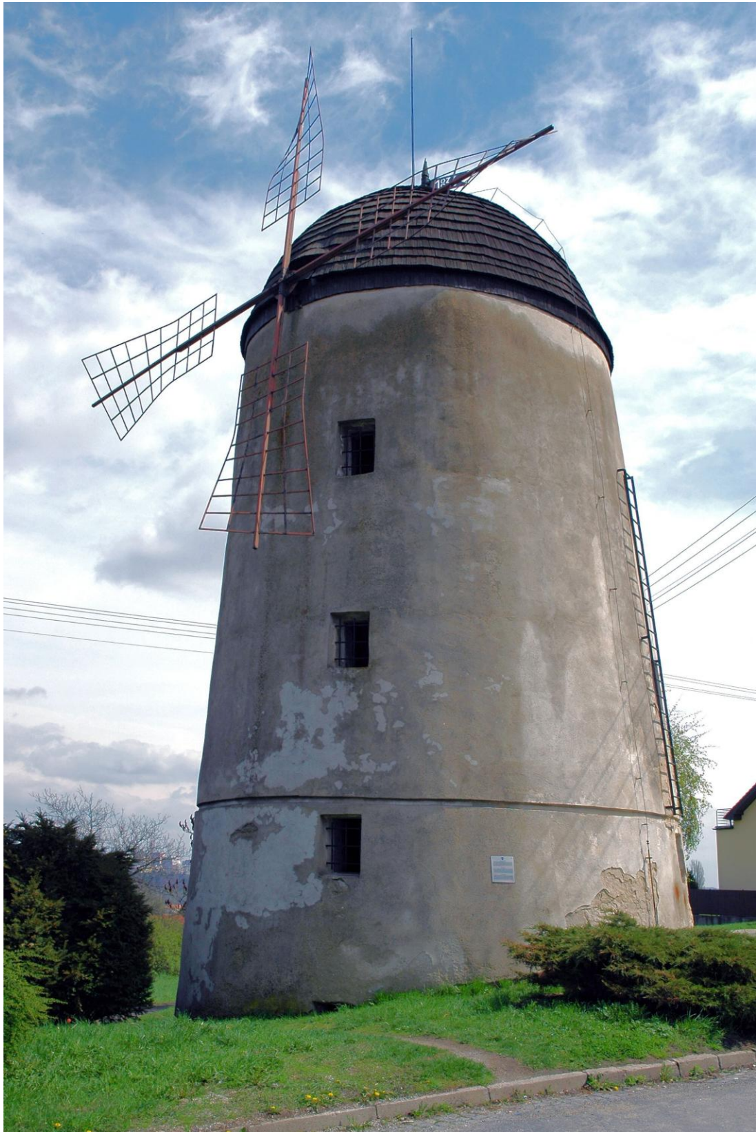
Větrný mlýn pro mletí kůry na výrobu třísla, součást továrny Budischowského
